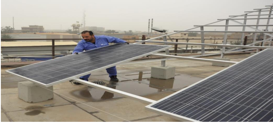
شكل (٢-٢) يوضح نصب الألواح الشمسية على الهيكل الحديدي
