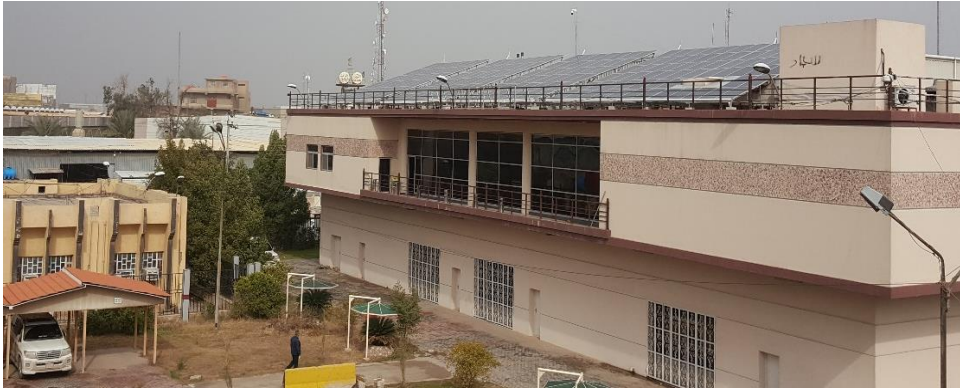
الشكل (٢-٣) لمنظومة kW PV –Solar system ١٠٠ المنصوبة على مركز بغداد
