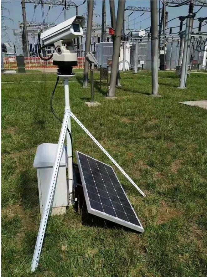
شكل 5-17. جهاز ليزر لابعاد الطيور من محطة الكهرباء
